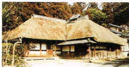
解体前の全景
